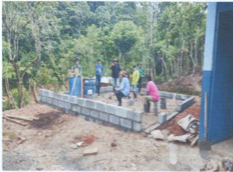
Foto 1: mejoramiento de cocina
