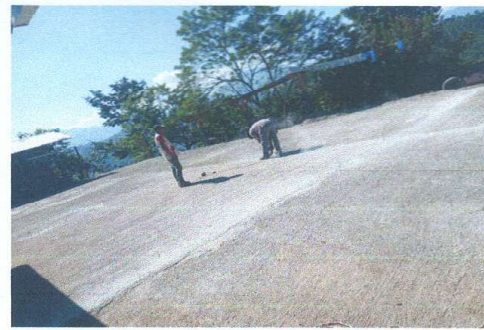
Foto 4: mejoramiento losa de patio
