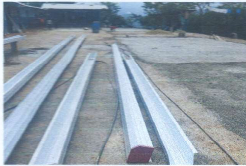
Foto 3: mejoramiento de canales
