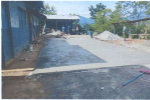
Foto 1: mejoramiento losa de patio
