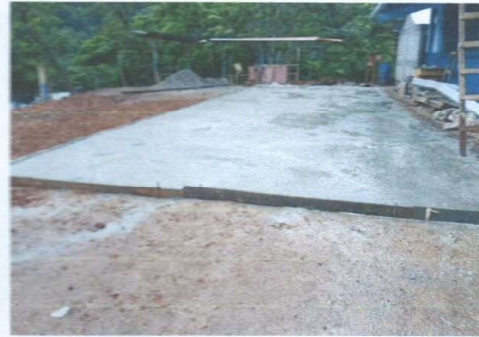
Foto 2: mejoramiento losa de patio
