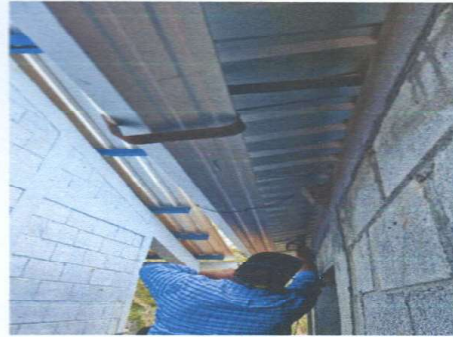
Foto 2: mejoramiento de canales
