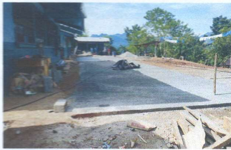
Foto 3: mejoramiento losa de patio
