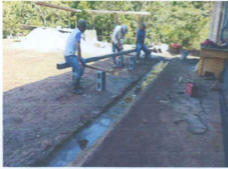
Foto 1: mejoramiento de canales
